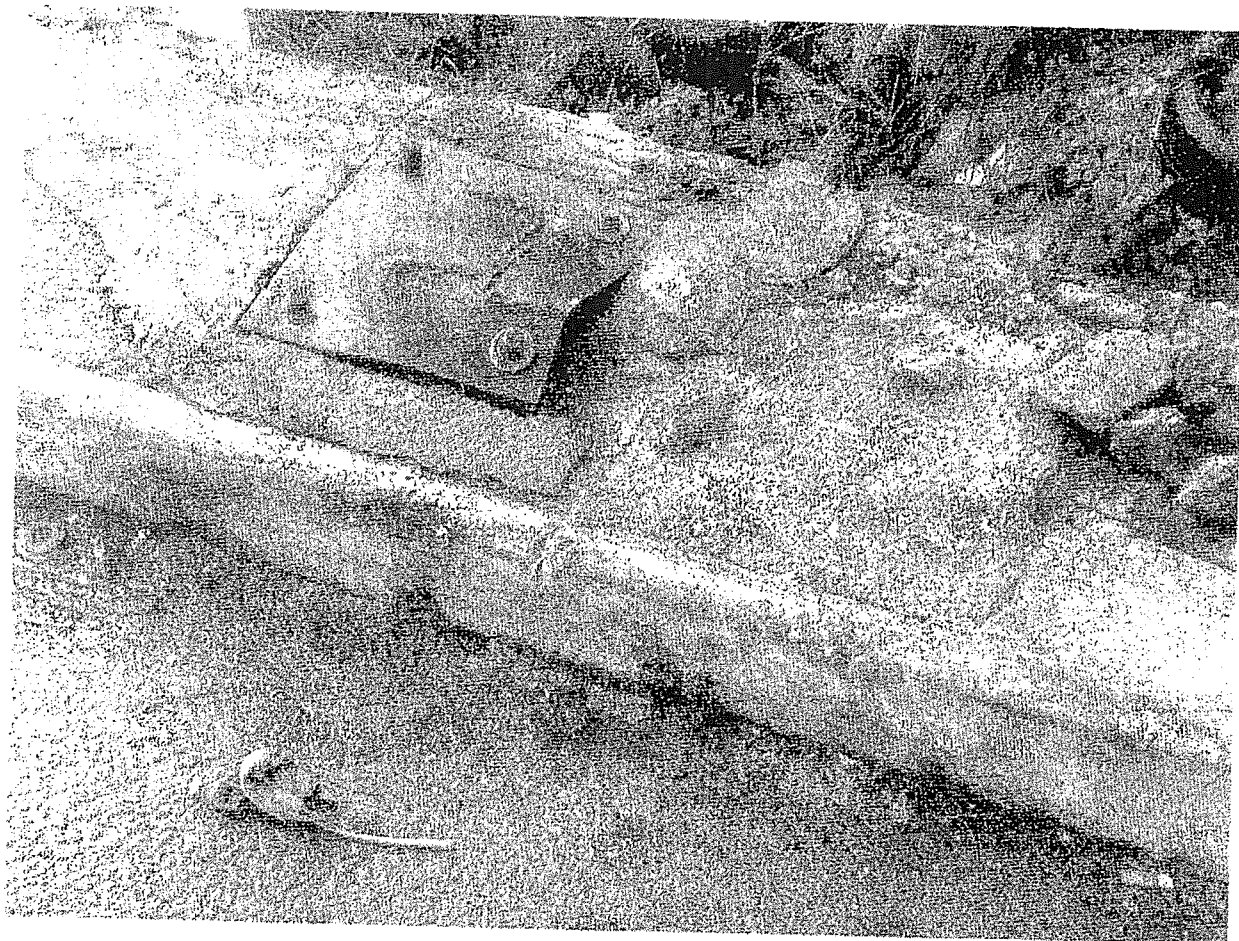
Particolare cordolo ancoraggio barriere incidentate
